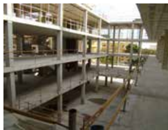
Proyecto en construcción.
