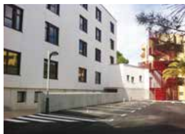
Fin de la Obra.
