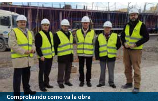
Residencia en construcción
