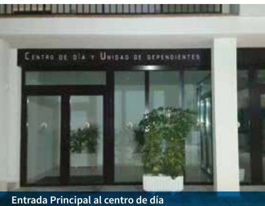
Frente edificio terminado
