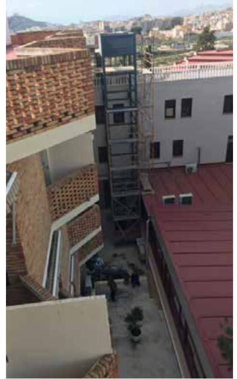
Otro ángulo del ascensor
