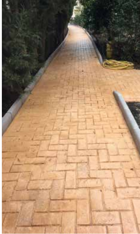
Hormigón impreso pasillo perimetral
