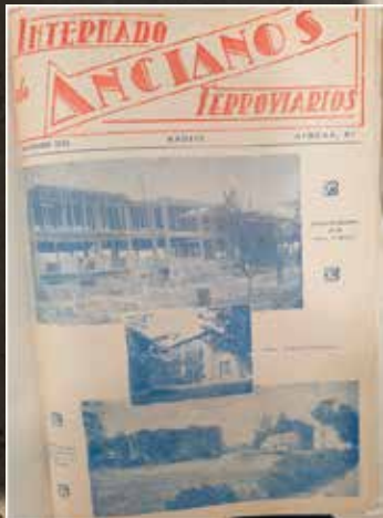
1950 construcción, la Pinada, terrenos San Juan
