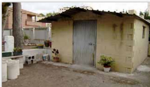
Almacén de mantenimiento de fontanería y albañilería
