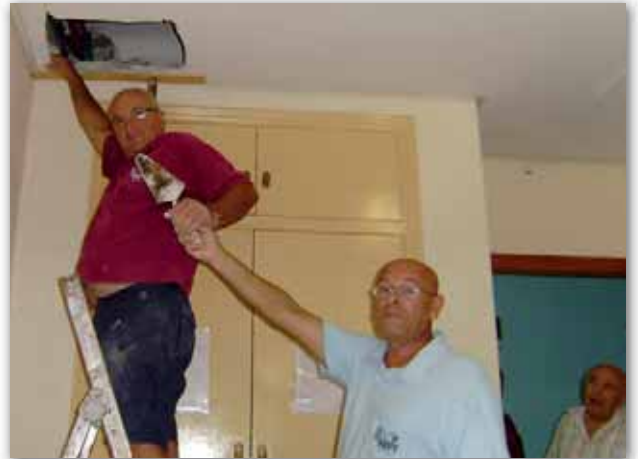
Reparación de avería en el circuito de agua
