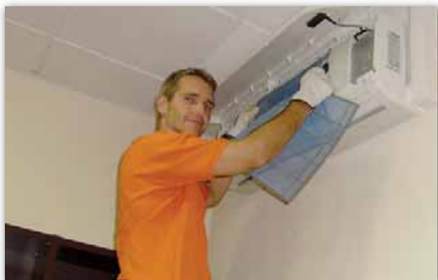
Revisión de filtros de aire acondicionado
