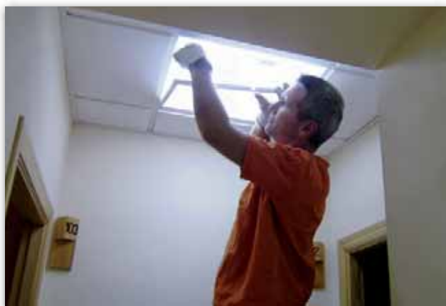
Reparando luminaria en pasillo de la Residencia
