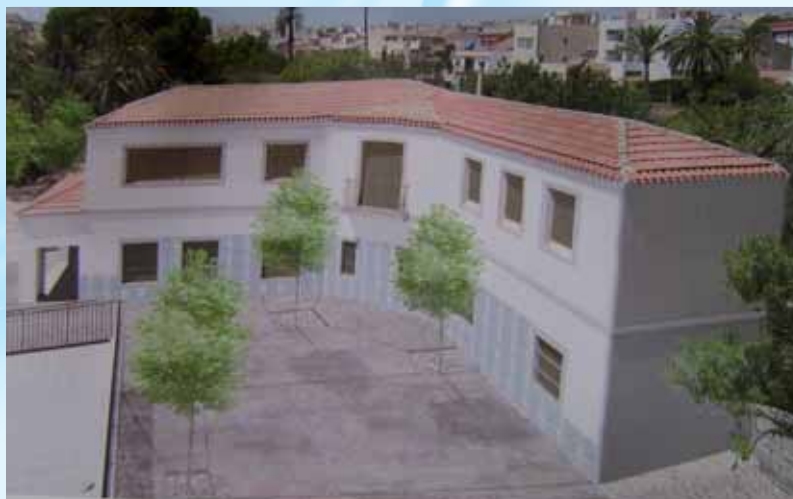
Proyecto de reparación de la casa del Molino (San Juan)
